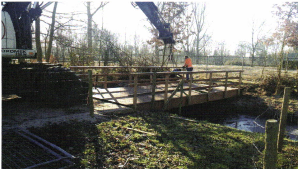
Foto: Nieuwe brug in aanbouw – Kinderboerderij Voorschoten
