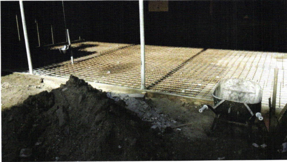
Foto: Aanleg vloeren en bestrating - Zorgboerderij Oliehoek
