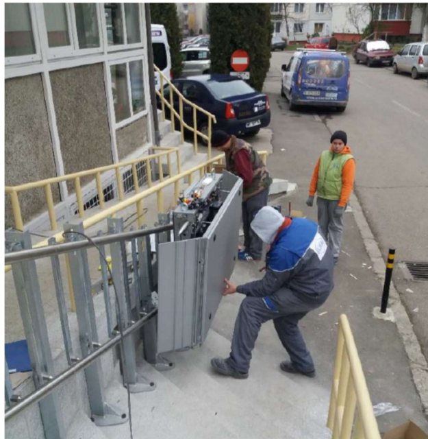
Foto: De rolstoelplateaulift in aanleg (bron: SBHvR)
